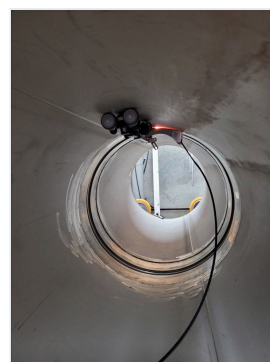
Pogled v notranjost cevi
